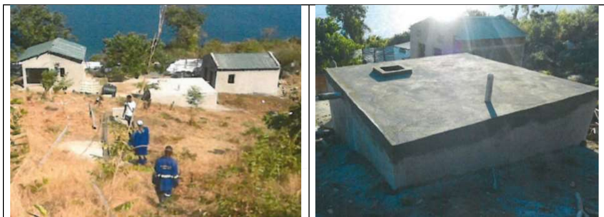
Figura 21 Edifícios na captação e reservatório de água tratada
