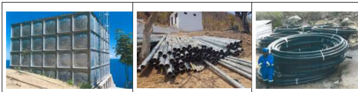
Figura 22 Reservatório metálico de distribuição instalado no topo do monte e tubagem de ferro galvanizado para adutora e copolene (plástica) para a rede de distribuição na vila
