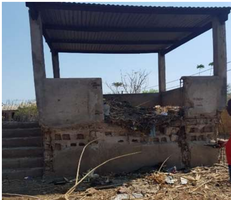
Figura 44 Imagem de silo elevado
