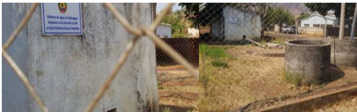
Figura 18 Captação constituída por poço e bombagem com a placa de inauguração do novo SAA (2007)
