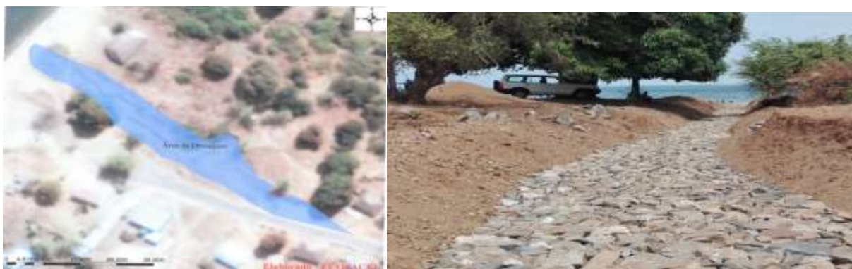
Figura 36 Projecto de drenagem no bairro Seli: área abrangida pelo projecto da vala (à esquerda) e aspecto de construção da vala (à direita)
