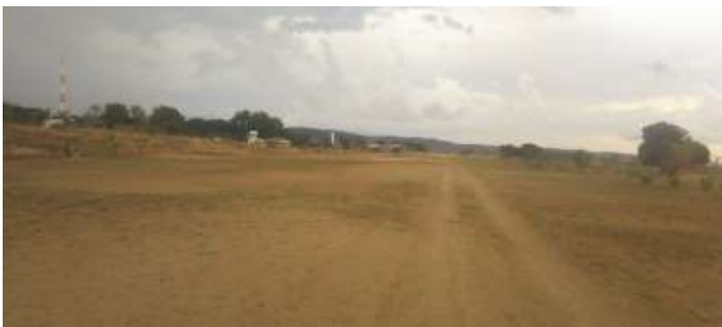
Figura 13 Vista parcial da pista do Aeródromo de Metangula
